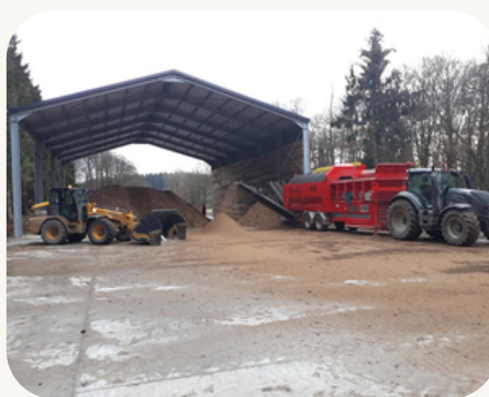
Chantier de criblage de plaquettes combustible (© Entreprise Pirothon)
